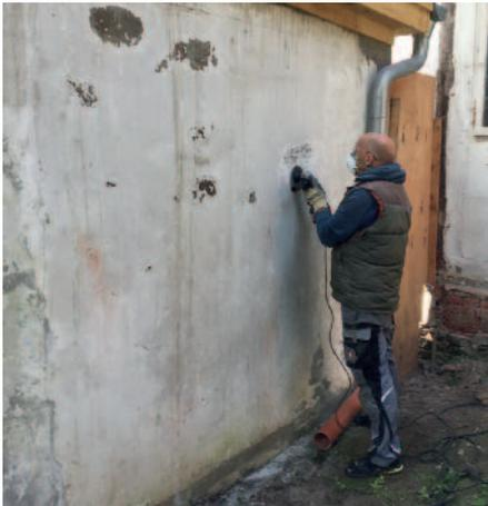
Im Außenbereich musste der Putz der Wände angeschliffen werden bzw. loser Putz entfernt werden als Vorbereitung für einen neuen Außenputz, den wir an Firma Borrmann vergeben haben. Und es musste der Sockel der Wände freigelegt werden, damit eine feuchteabweisende Schicht aufgetragen werden konnte. Dies haben Florian Butt, Andreas Dymale, Raimund
